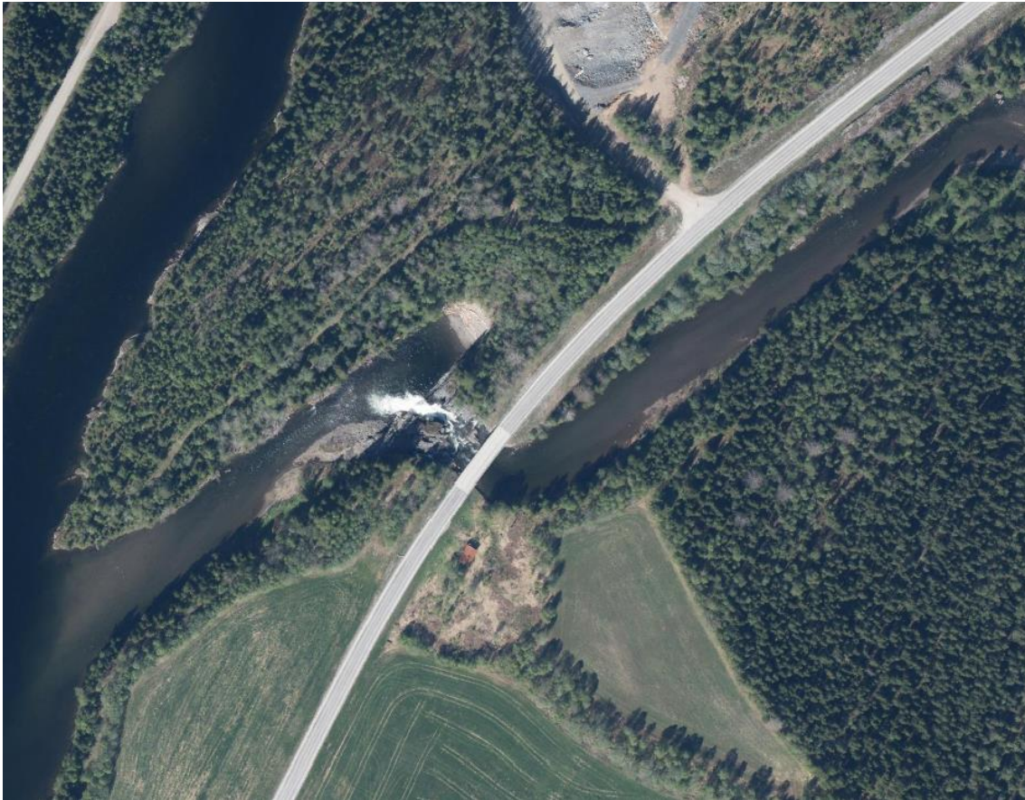
Figur 4: Figuren viser grovt sett landskapet og vegetasjonen rundt dagens bru over Stortromselva.
