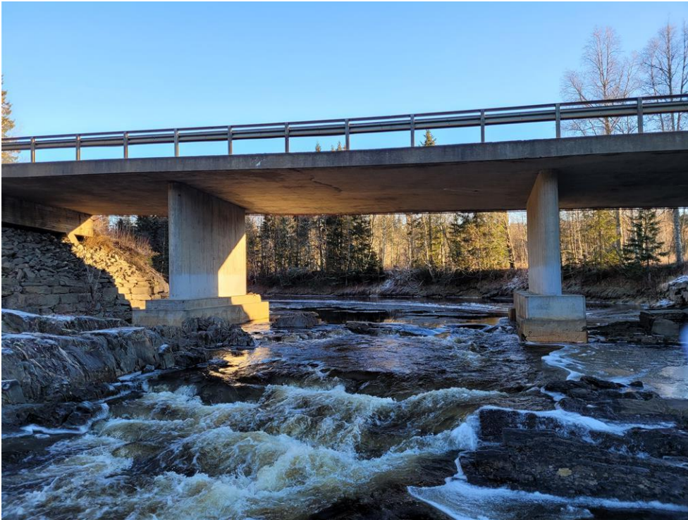
Figur 3: Støtteelement og fylling på nordsiden av elva.
