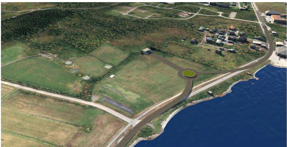
Figur 36 Illustrasjon av tunnelpåhugg på Holt sett fra nordvest
