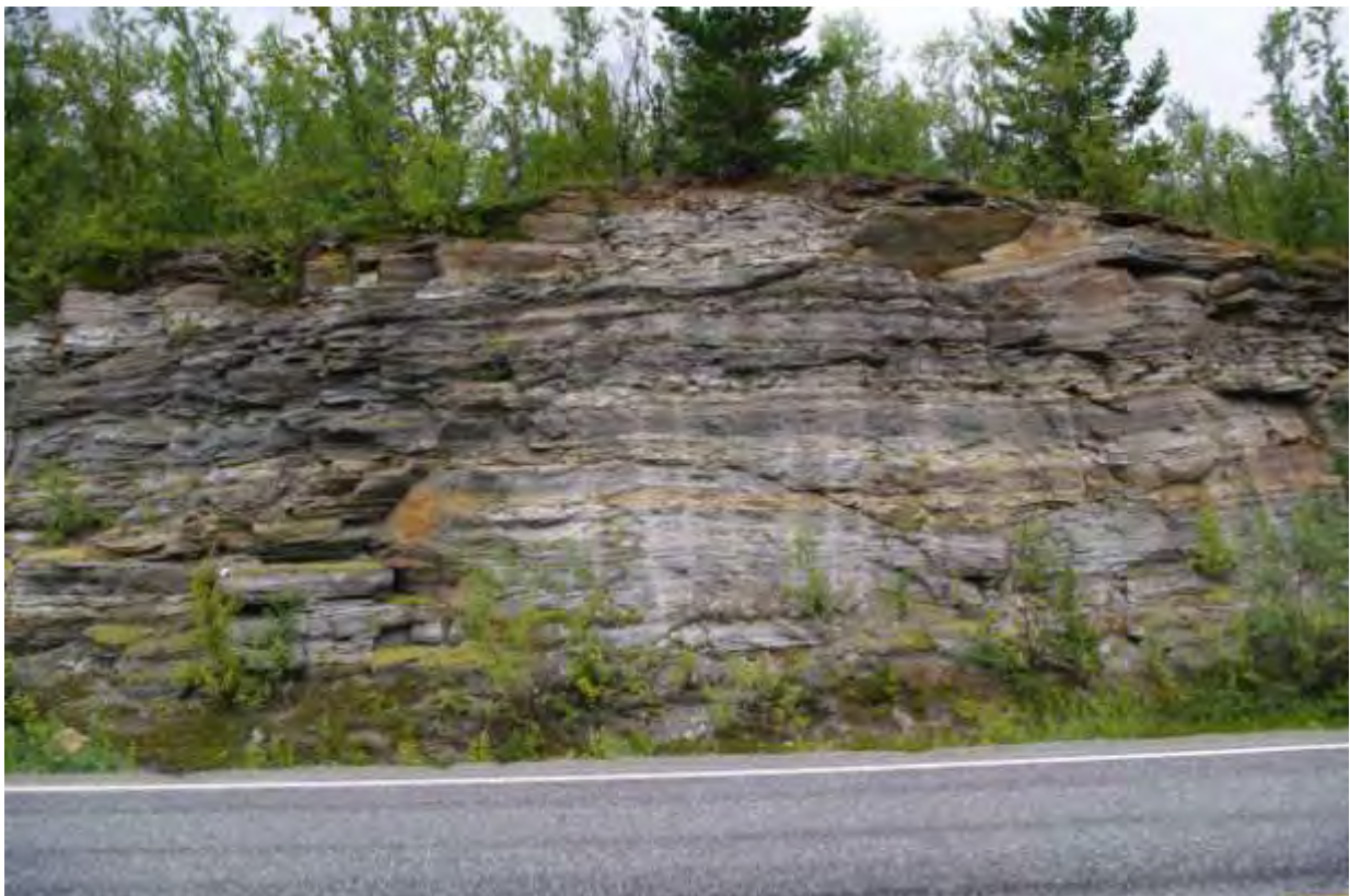
Bilde 12 Ca 4m høy skjæring ved p. 2255 (GPS 315). Stort sett plan foliasjon.
