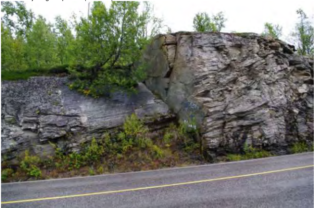
Bilde 18 Plan gjennomgående sprekk i parti med hardere fjell ved p. 3325 (GPS 323).
