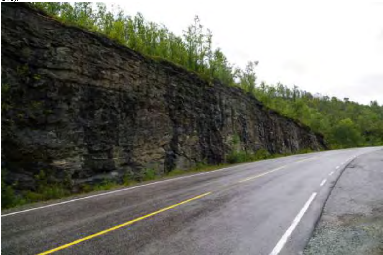
Bilde 16 Skjæring mellom p. 3130-3220 (GPS 320-321).
