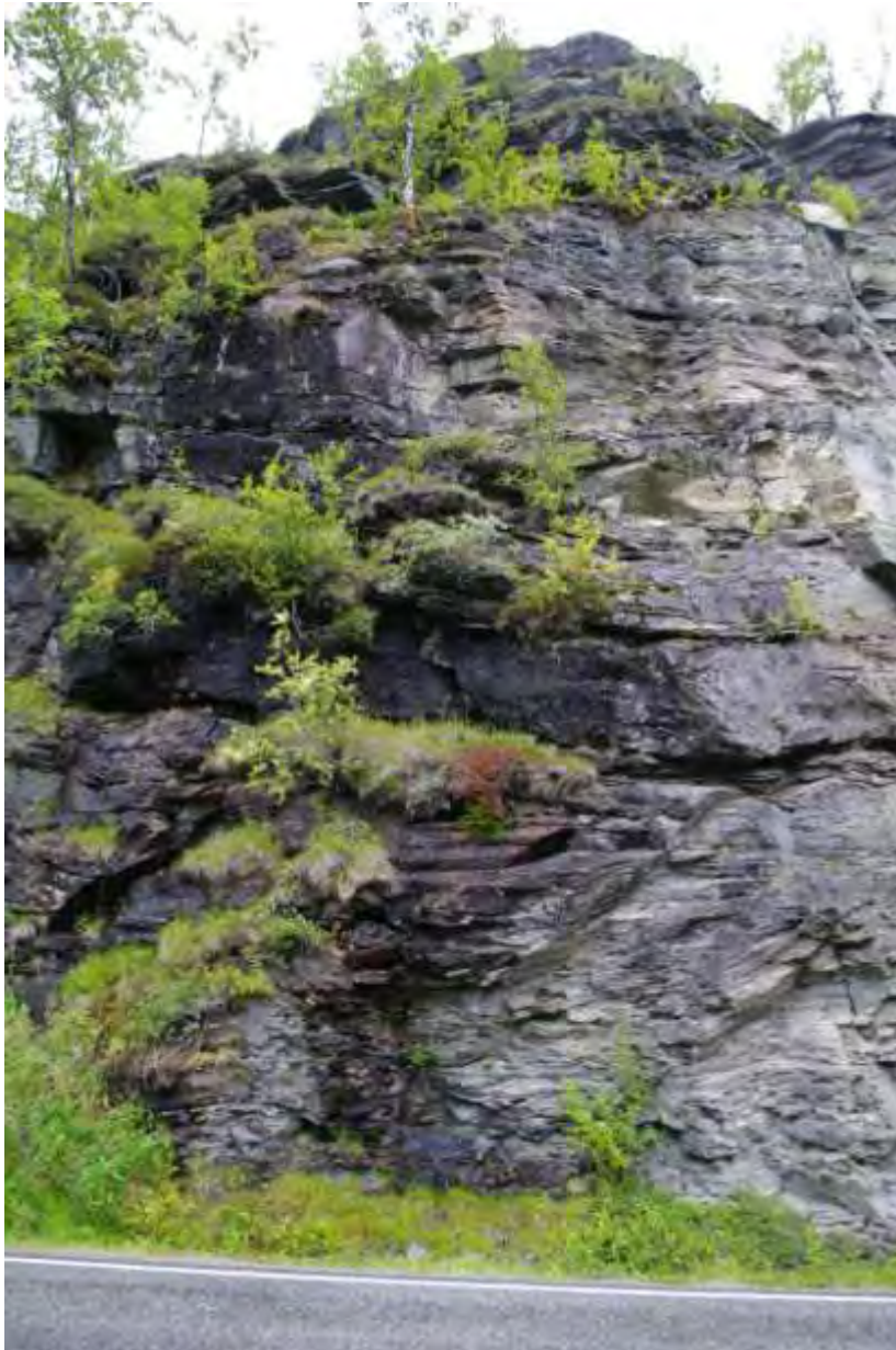
Bilde 21 Start høy skjæring ved p. 3680 (GPS 325).
