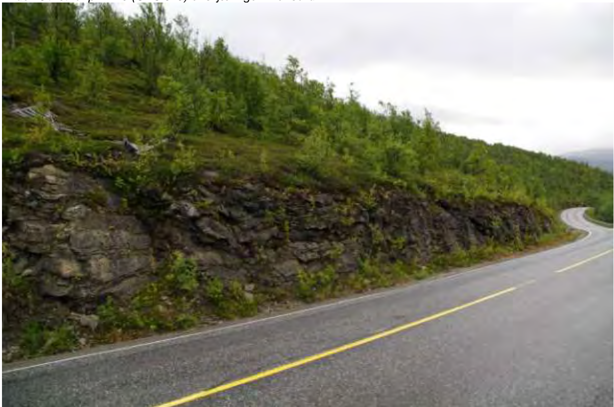
Bilde 29 Typiske fjellforhold mellom p. 5040 og 5185 (GPS 330 og km 21,5). Lave skjæringer med foldet foliert fjell med fall ca 20° inn mot veggen.
