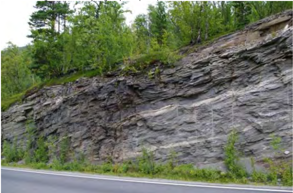
Bilde 10 Solidere fjell i nedre del av skjæring ved p. 1800 (GPS 312).
