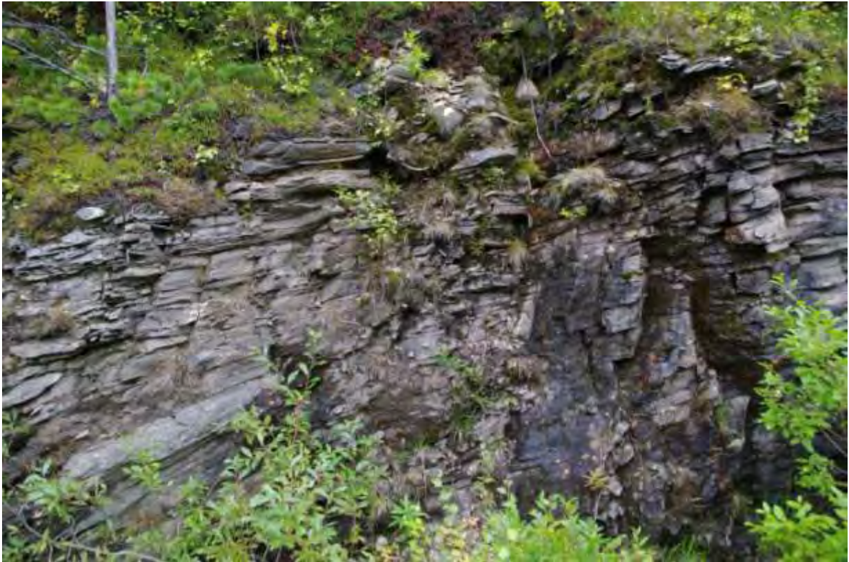
Bilde 9 P. Vannsig i eksisterende skjæring ved p. 1590 (Km 25).
