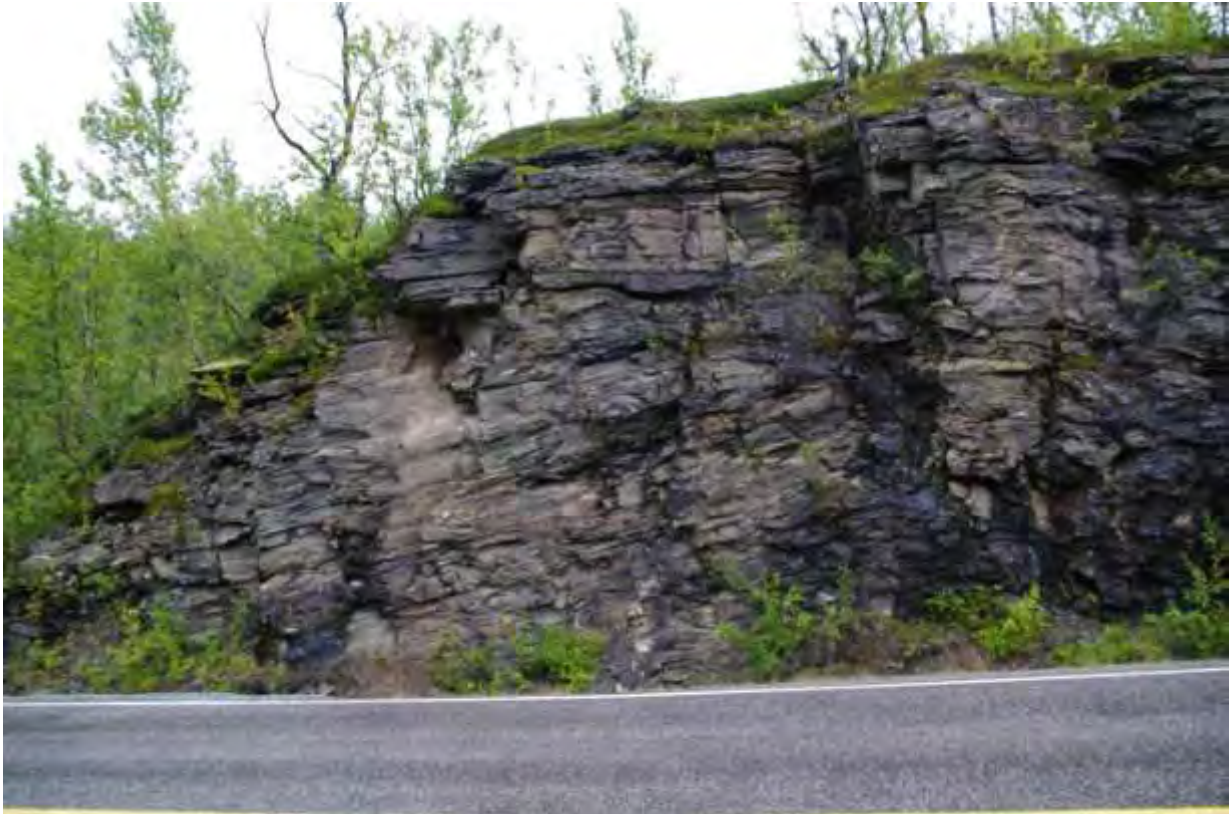
Bilde 17 Skjæring ved p. 3300 (GPS 322). Noe hardere men mer småfallent i overflaten
