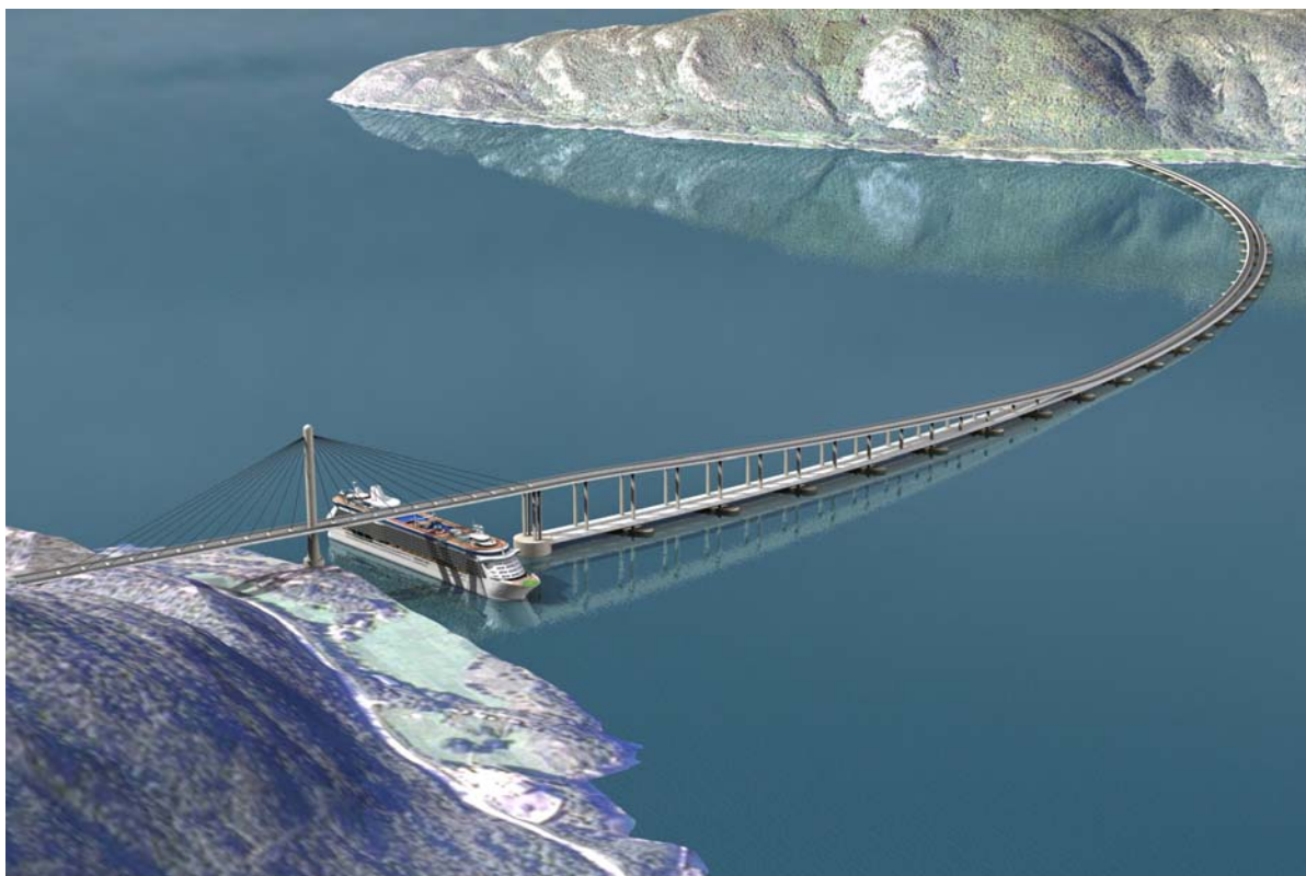
Figur 3: Oversikt flytebru med fastbru over utsprengt strandsone
