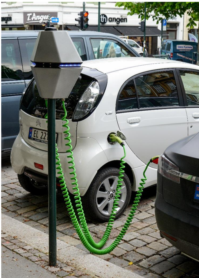
Foto: Knut Opeide, Statens vegvesen
