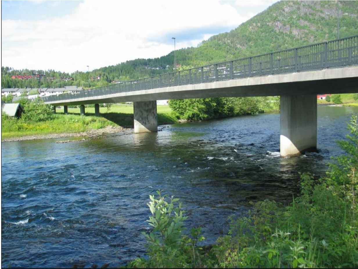
Døme på betongplatebru, Viabrua i Førde (bilete frå fylkesarkivet.no)
