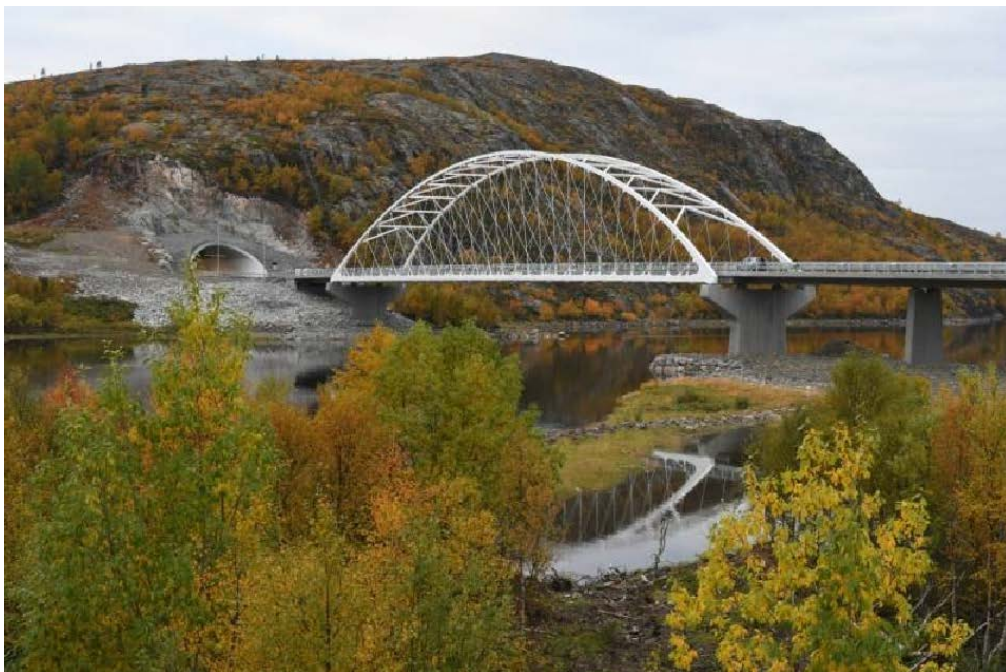
Døme på nettverksbogebru som går over i ei platebru, Bøkfjordbrua (bilete frå vegvesen.no; foto Knut Opeide).
