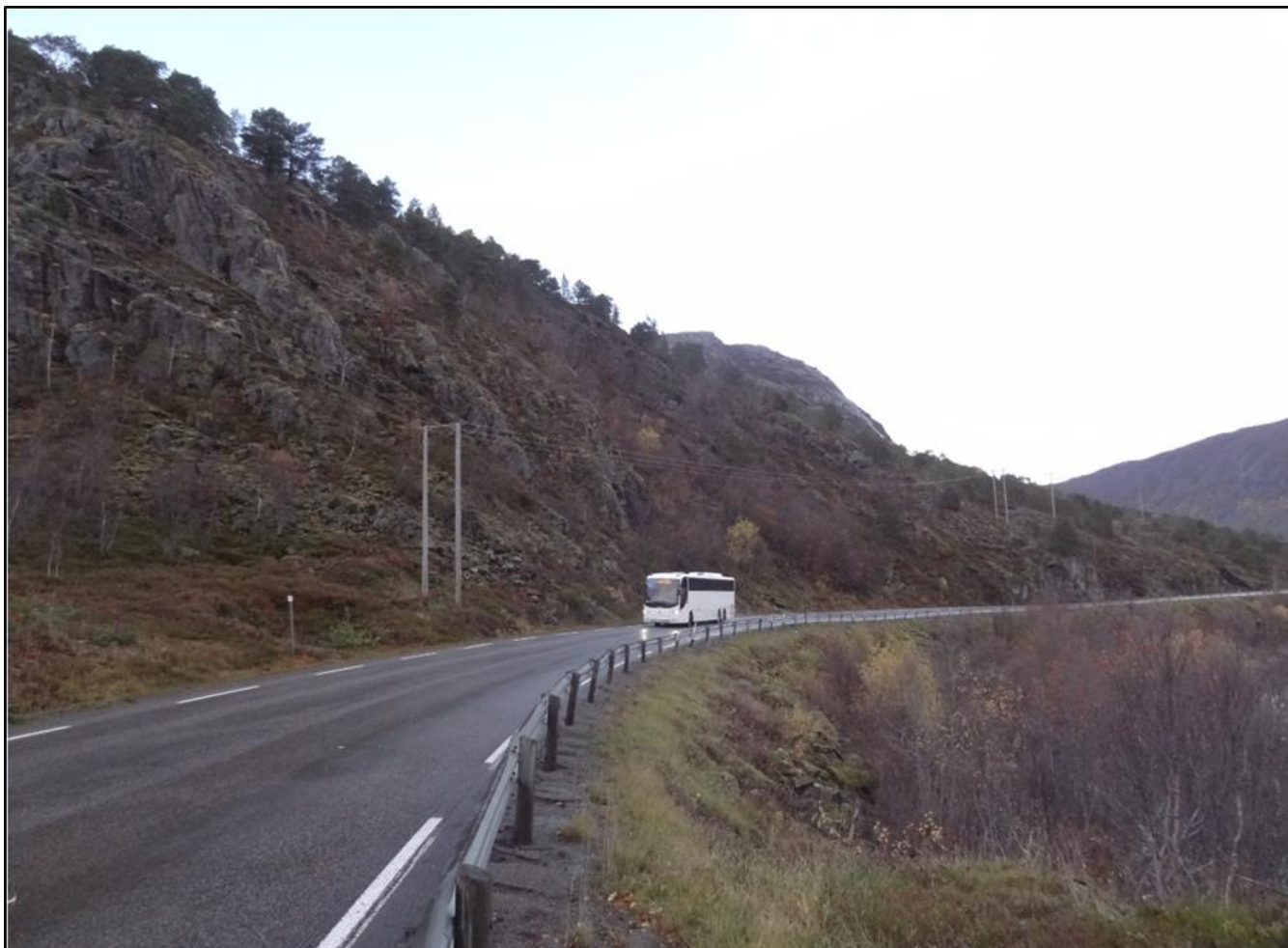
Figur 31: I Forvika passeres bratte skredutsatte fjellsider, sett mot nord. Foto: Ole-André Helgaas
