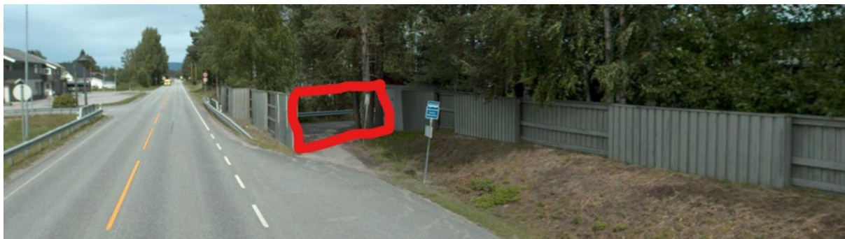
Figur 29: Dagens smett i støyskjermen ved Vestad skole (Statens vegvesens vegbilder)
