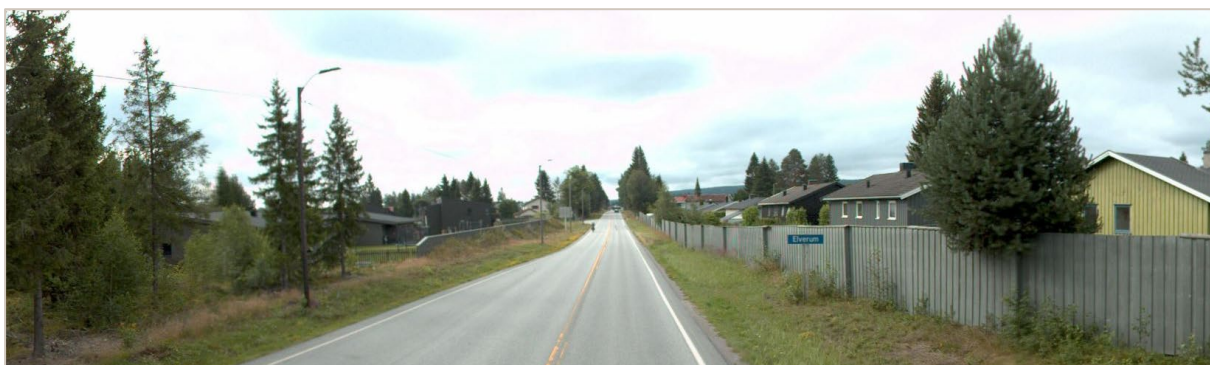
Figur 11: Trondheimsvegen sett sørover fra Mårvegen (Statens vegvesens vegbilder)
