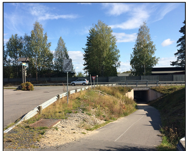
Figur 9: Kulvert mellom Elgvegen og Vestad skole
