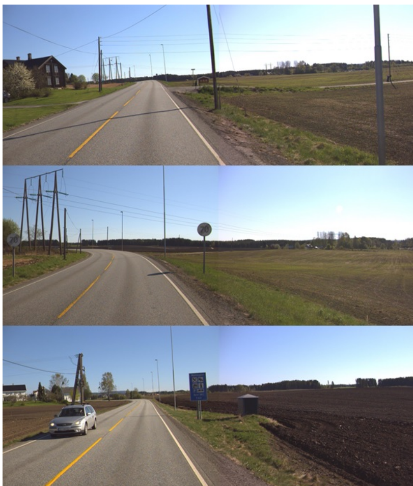
Figur 10 Bilder fra Statens vegvesen. Øverst: Rv. 3 nordover ved Skramstadødegården. Midten: Kryssende høyspentledning nord for Skramstadødegården. Nederst: Nettstasjon på eiendomsgrensen mellom Vollestad og Sigstad gårder
