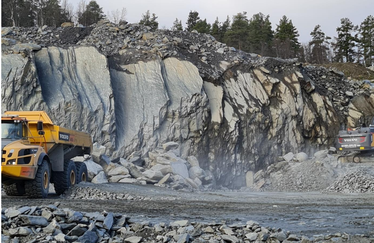
Figur 10: Ny blotning av skifrig kvartsitt i anlegget, ca. profilmeter 2350
