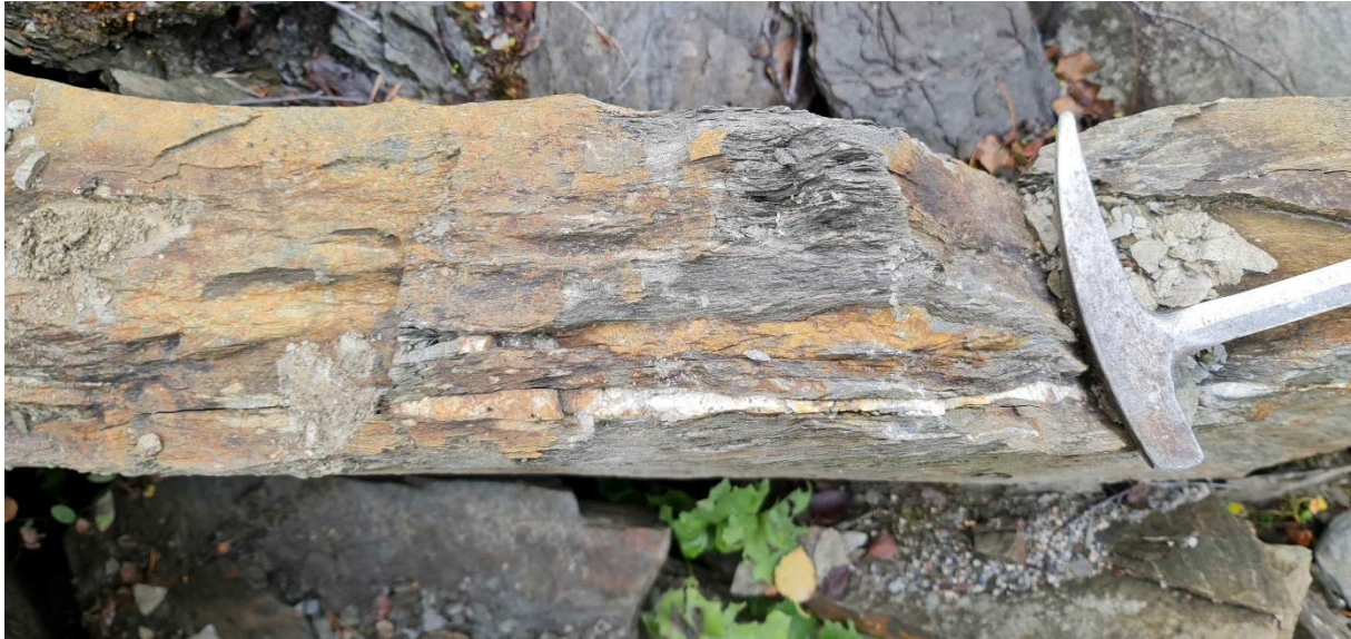
Figur 26: Ubetydelig, rustaktige misfarging, kan mest sannsynlig knyttes til glimmer- og klorittforvitring, på sprekkeflater av glimmerskifer, ved slutten av nåværende veiskjæringen, ca. profilmeter 3000
