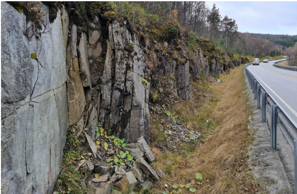
Figur 17: Benket kvartsitt med tydelige lagflater, ca. profilmeter 3050
