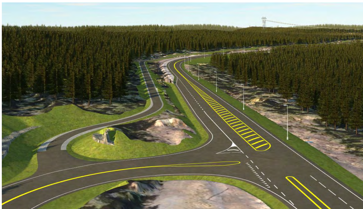
Figur 31: Gang- og sykkelveg på vestsiden av rv. 4. Viser strekke der Hengedyvegen går i felles trase. Viser også oppgradert avkjørsel til pukkverk.
