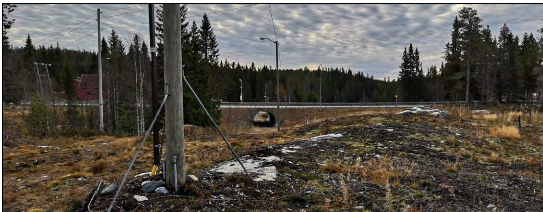
Figur 18: Eksisterende kulvert under rv. 4 forbinder skiløyper på tvers av planområdet
