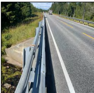
Figur 39: Aktuell bro/betongkulvert som erstattes med fiskevennlig rør.
