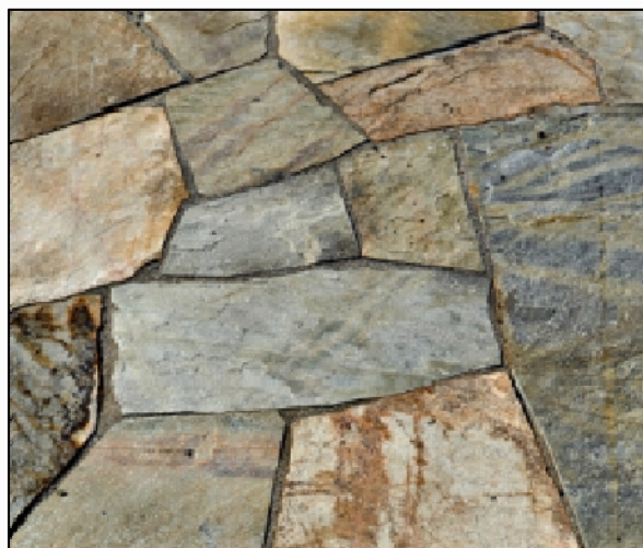
Eksempel på hvordan naturstein ønskes lagt i bruddhellemønster i deleøyer og smale rabatter
