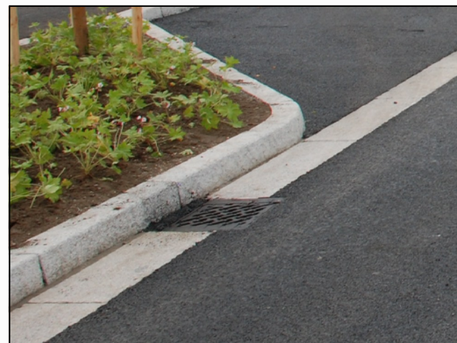
Eksempel på nedfelt, bred kantstein lagt som rennesteinsfelt
