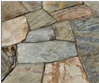
Eksempel på hvordan naturstein ønskes lagt i bruddhellemonster i deleøyer og smale rabatter
