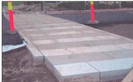
Eksempel på hvordan enkelte fotgjengeroverganger i miljøgata kan fremheves spesielt med rektangulære granittheller
