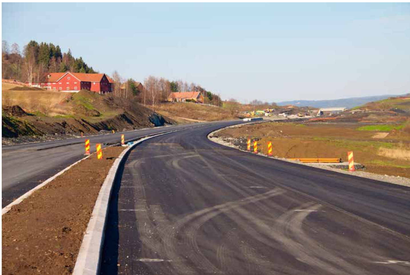
Den søndre delen av Gran-parsellen ble asfaltert i høst. I bakgrunnen ser vi nye Vøyen bru. Foto: Frank Andersen
