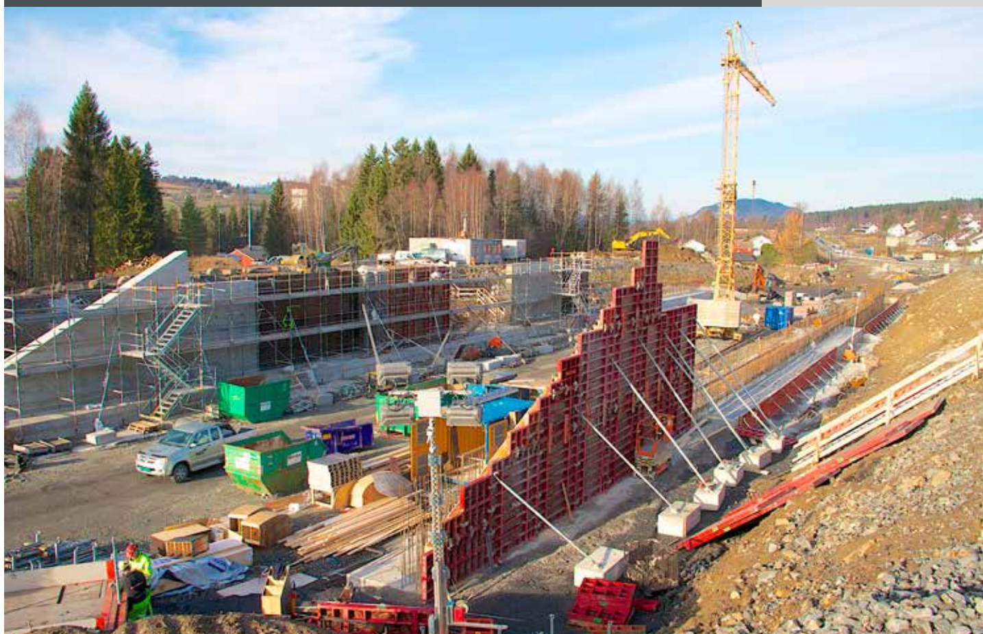
Arbeidet med nytt kryss på Haugsbakken på Jaren er godt i gang. Foto: Frank Andersen
