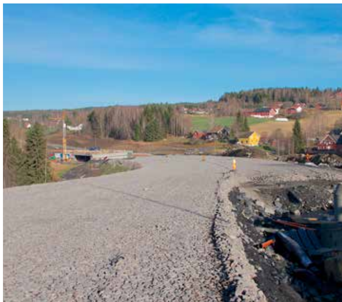
Arbeidet med ny bru i Kolstadsvingen er i gang. Foto: Frank Andersen
