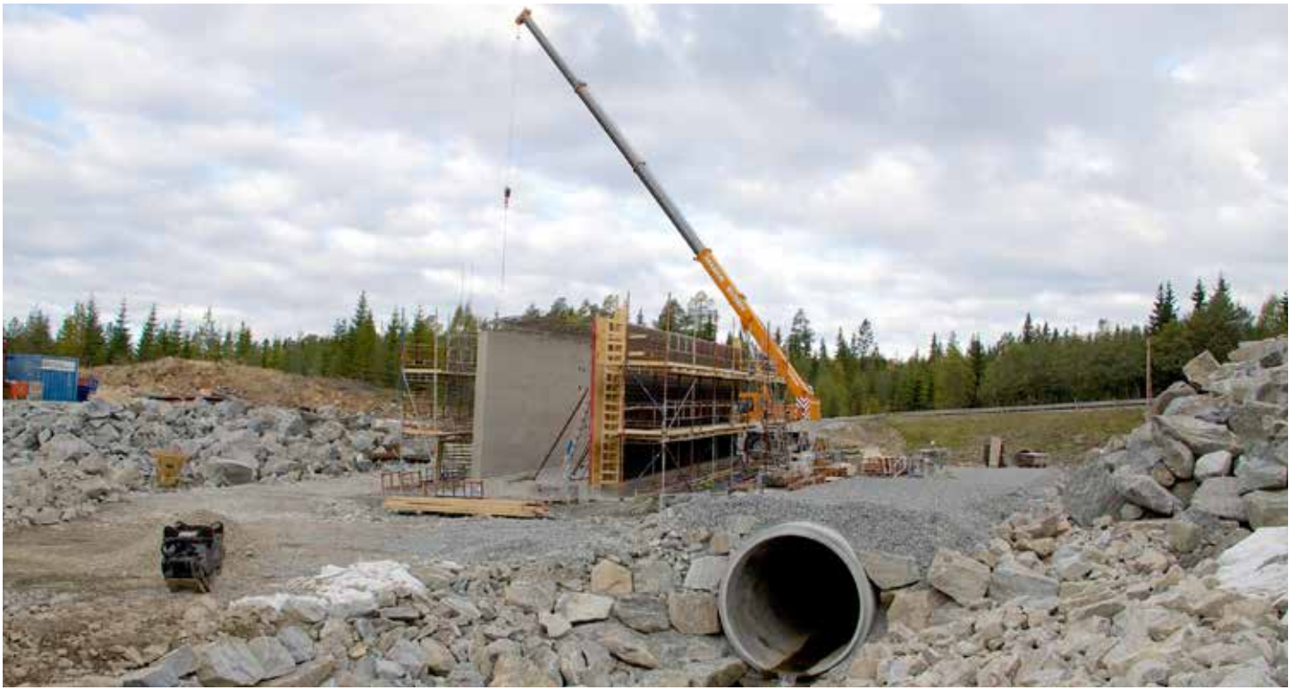
Kulverten som Badstuvegen skal gå i på Lygna sør skal være ferdig bygget etter nyttår.
