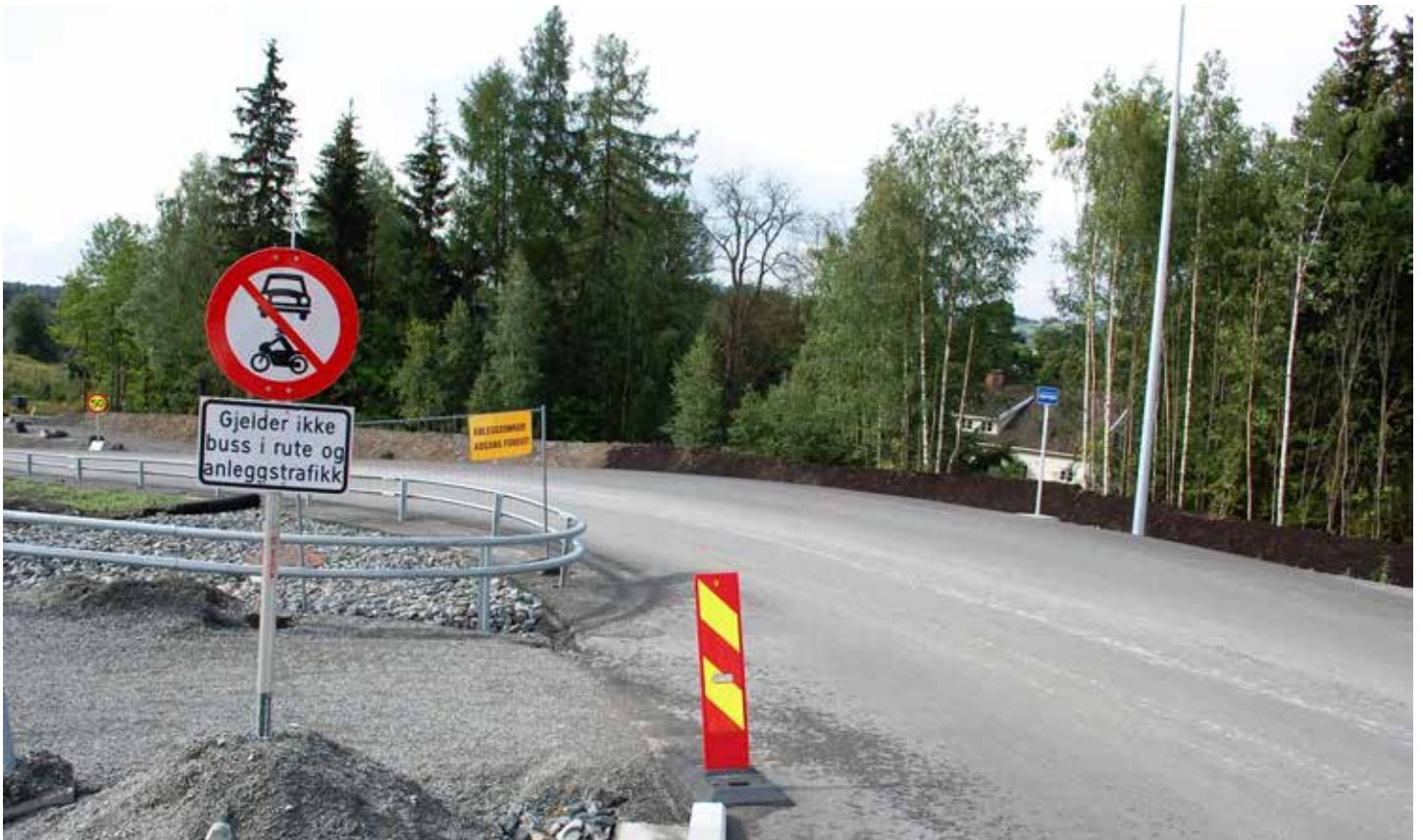
Statens vegvesen minner om at det er adgang forbudt innenfor anleggsområdet hvor ny riksveg 4 bygges. Foto: Einar Sjøberg
