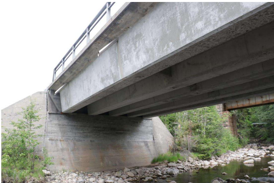
Figur 6-5: Bilde av brua ved Trommald.
