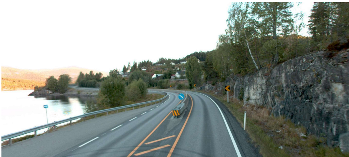
Figur 8-1: Midtdeler som sikkerhetstiltak i svingen nord for Trommald. (Kilde: vegkart.no)
