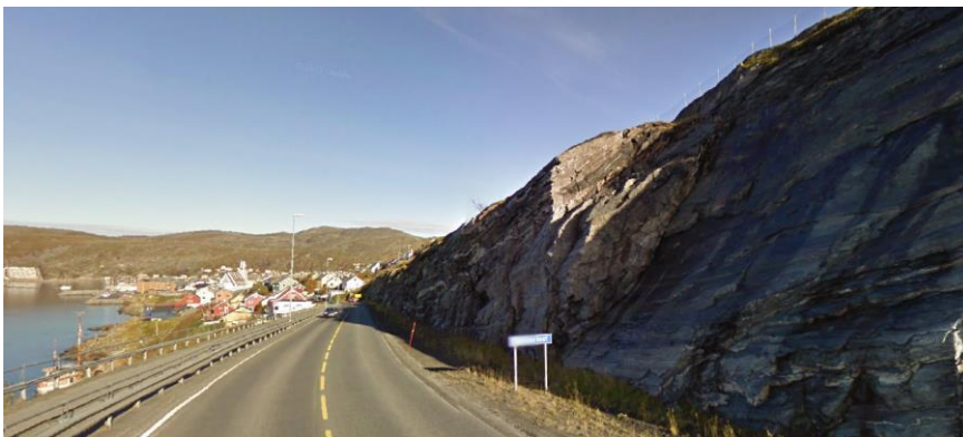
Figur 7. Dagens situasjon ved planlagt nødutgang sør, Salentunnelen
