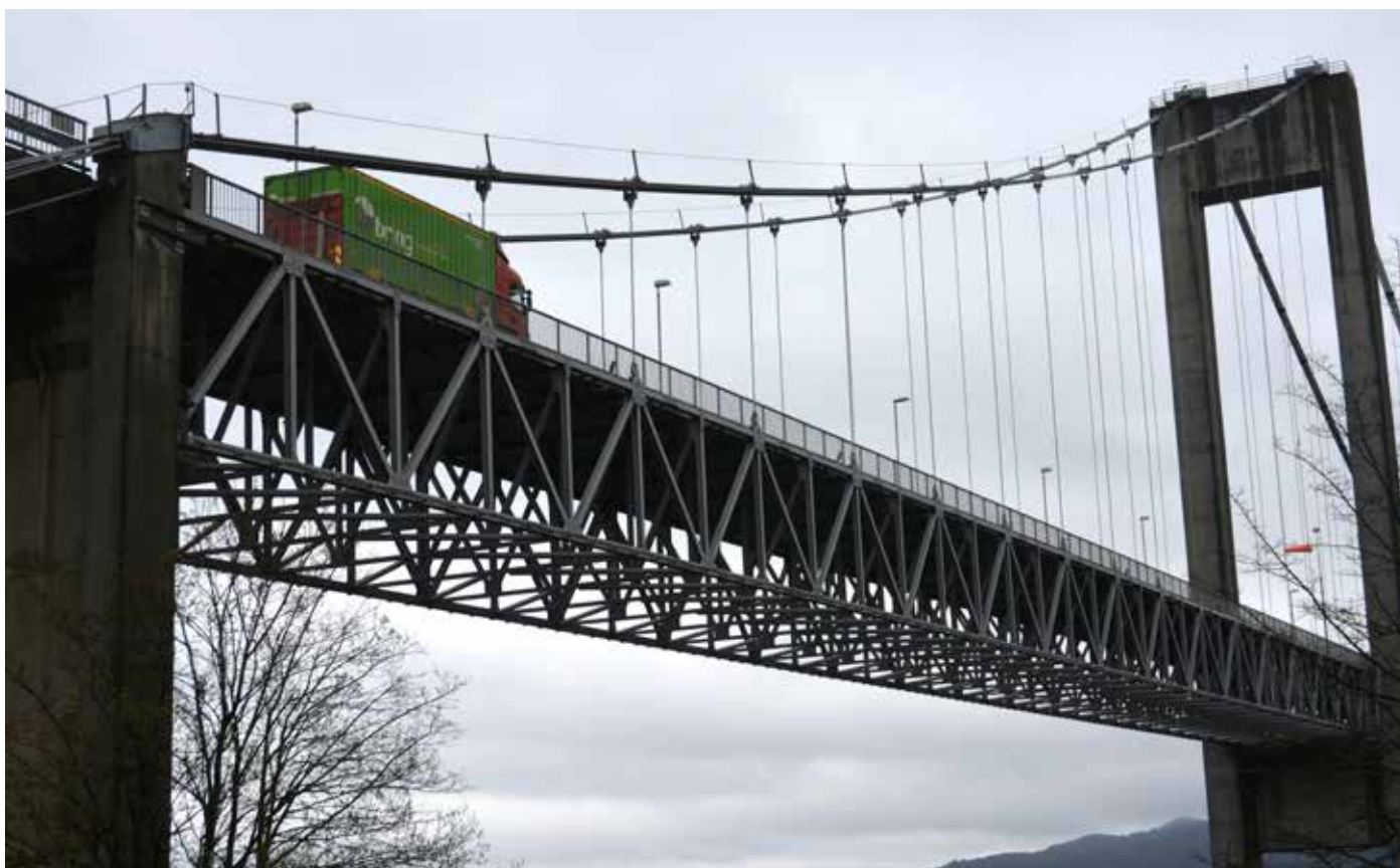
Høyspentkablene skal flyttes til dagens bru – på kabelkasse gjennom fagverket og viaduktene på hver side av fjorden. Foto: Geir Brekke
