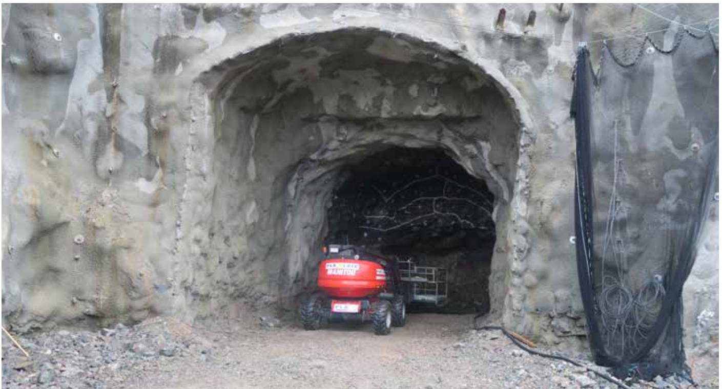
Boring og sprengning av kabeltunnell er igang. Her fra Knarrevik. Foto: Tor Arne Hagen
