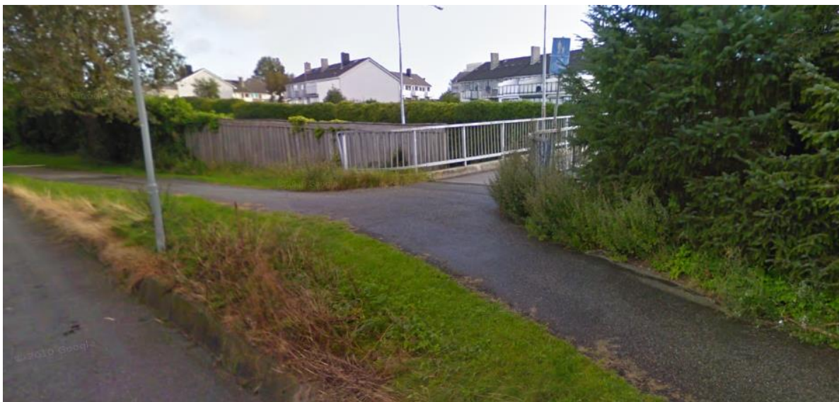
Figur 27: Dagens situasjon ved g/s-vegbro over E39 ved Polarveien
