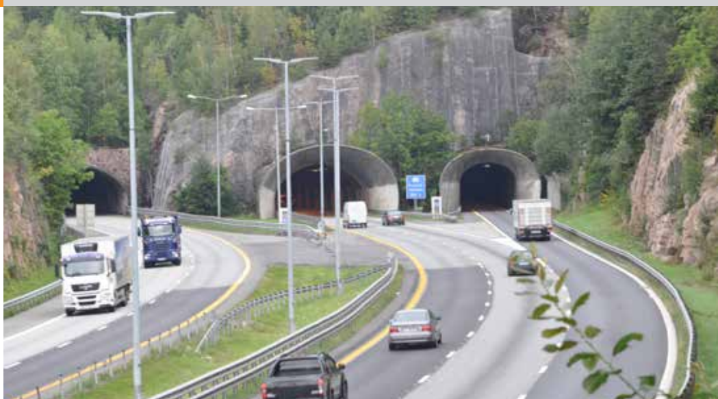
Fosskollentunneln sett sørfra. (Foto: Kjell Wold)
