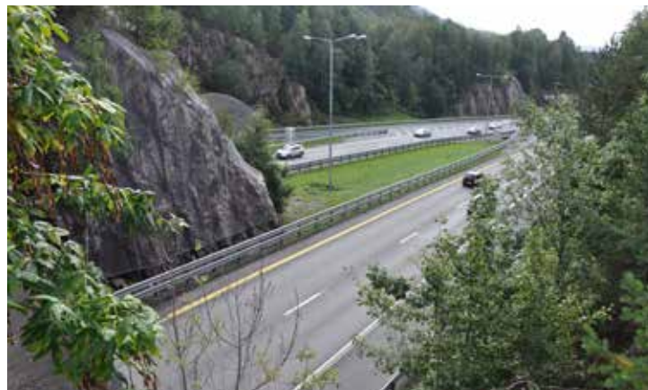
Det blir trafikkreguleringer i begge retninger i byggeperioden. (Foto: Kjell Wold).
