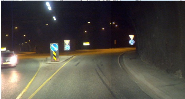
Rundkjøring i tunnel
