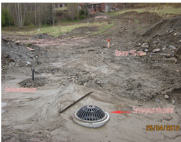
Sandfangskum, bakkekran og stakerør. Foto Terje Rønneberg
