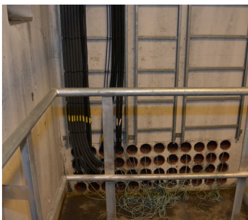
Trekkerør inn til hovedfordeling. Foto: Tore Paulsen
