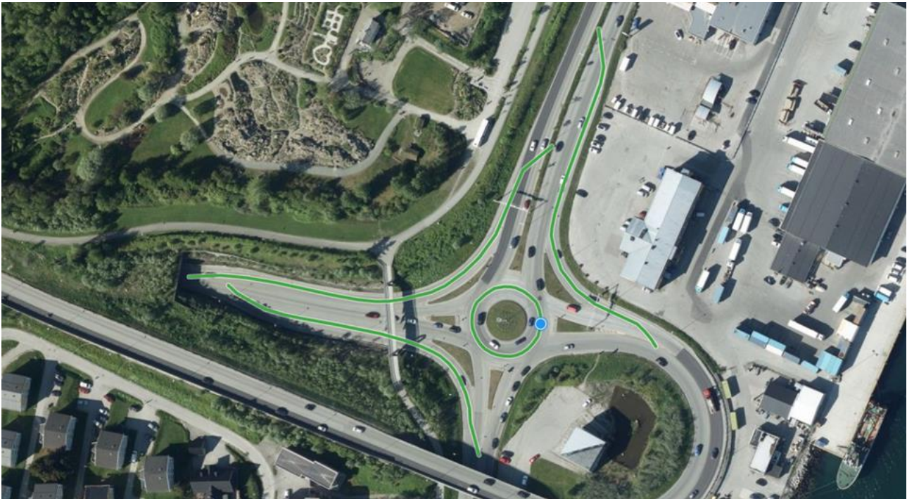
Figur 1 Kryssystem, her merket som blått punkt, bestående av rundkjøring og egne avkjøringsfelt for E8 i Tromsø. (Foto: Fra Vegkart)
