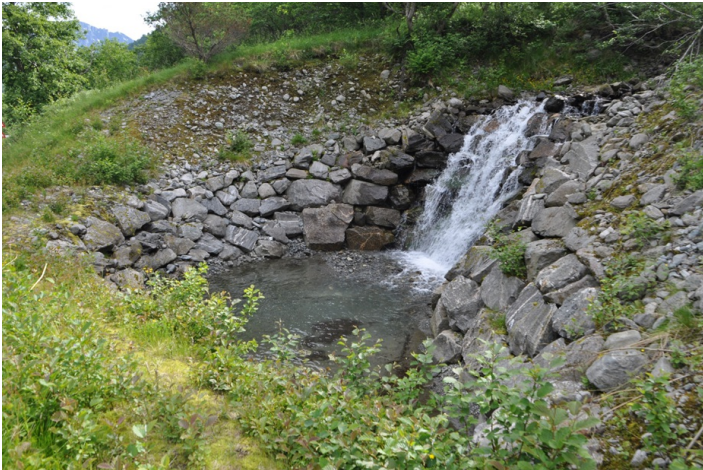
Figur 7: Sikring for sørpeskred/flomskred. Foto: Marie Drågen
