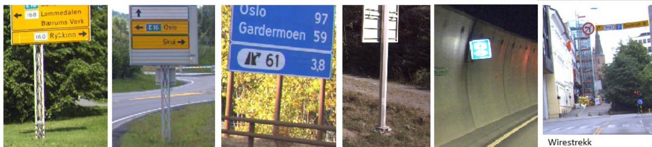
Gittermast, trekant varierende størrelser Gittermast firkant varierende størrelser Søyle, rund eller åttekantet liten, middels, stor eller angitt størrelse Vegg Skiltbjelke/gitterdrager i tak Wirestrekk
