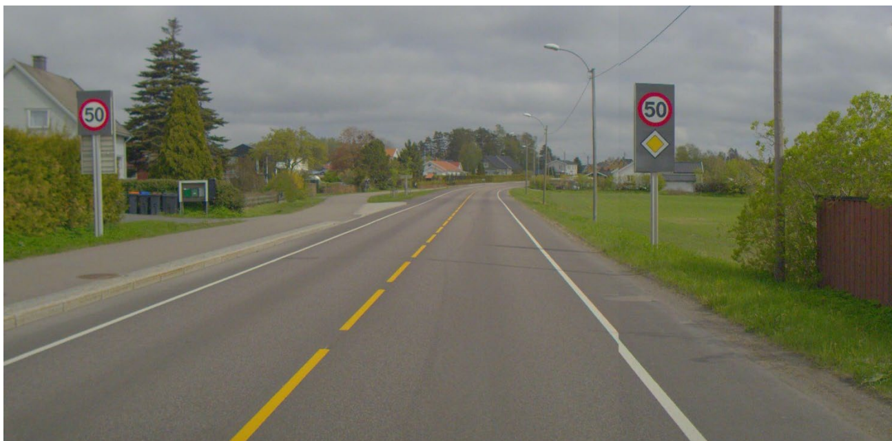
Fartsgrense (Foto: Vegbilder, Statens vegvesen)
