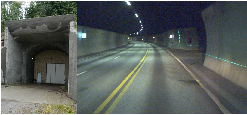
Tverrslag på utsida og i tunnel
