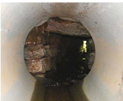
Figur 8: Stikkrenne som er forlenget
