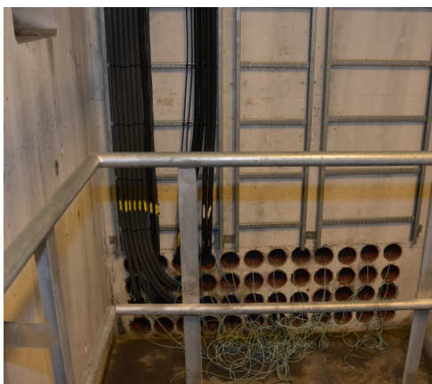
Trekkerør inn til hovedfordeling. Foto: Tore Paulsen
