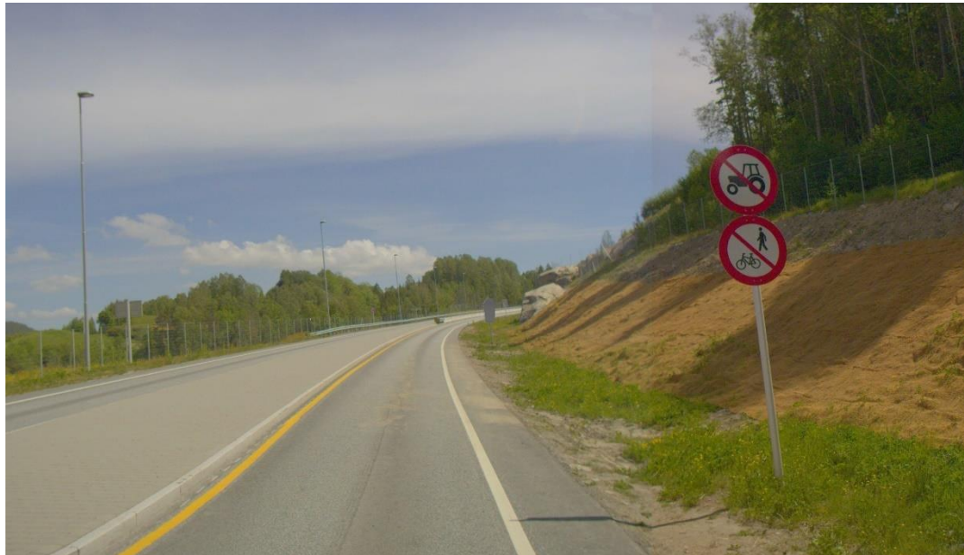
Figur 1 Trafikkreguleringer (Foto: Statens vegvesen)
