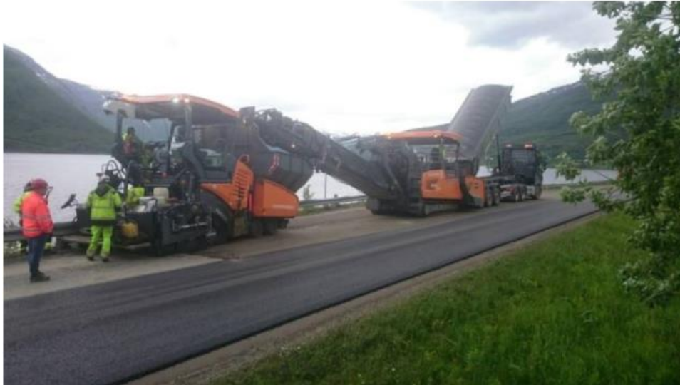
Figur 1 Vegdekke (Foto: Kåre Nygård, Statens vegvesen)
