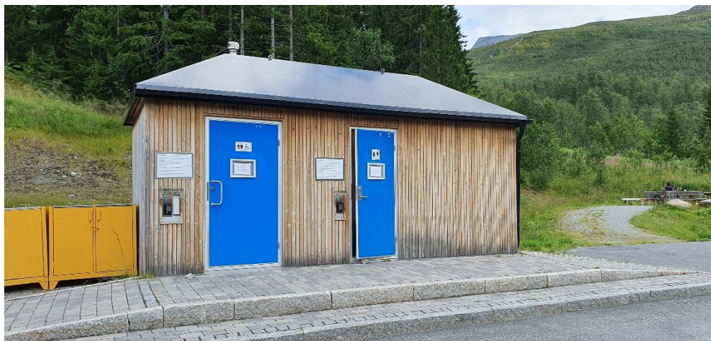
Figur 1 Toalettanlegg (Foto: Randi Skoglund, Statens vegvesen)
