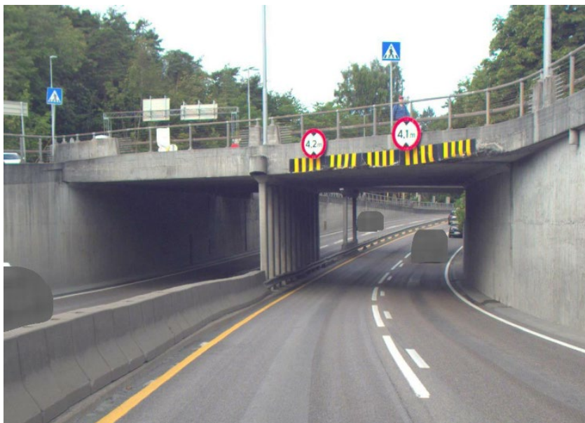
Retning mot Drammen, mot metreringsretning (felt 2 og 4)
