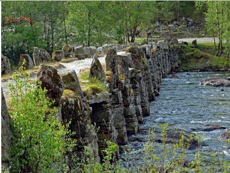
Foto: Geir Magnus Tunland, Statens vegvesen
