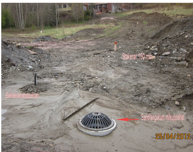
Sandfangskum, bakkekran og stakerør. Foto Terje Rønneberg
