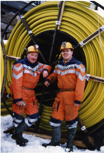
Figur 3: Trekkerør på trommel. Foto Charlotte V. Nielsen
