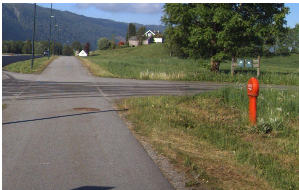
Figur 1 Brannhydrant til høyre i bildet (Foto: Statens vegvesen)
