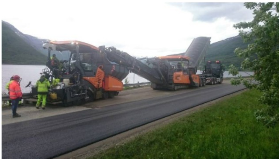
Figur 1 Vegdekke (Foto: Kåre Nygård, Statens vegvesen)
