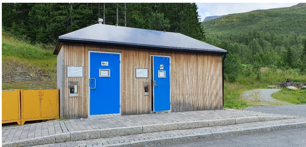
Figur 1 Toalettanlegg (Foto: Randi Skoglund, Statens vegvesen)
