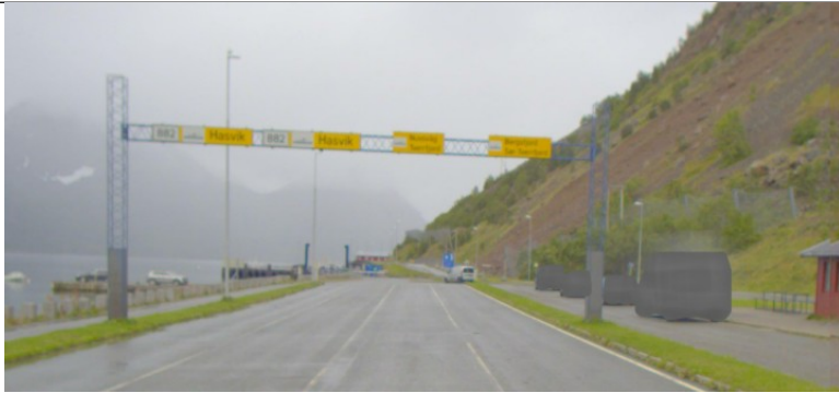
Foto: Vegbilder, Statens vegvesen
