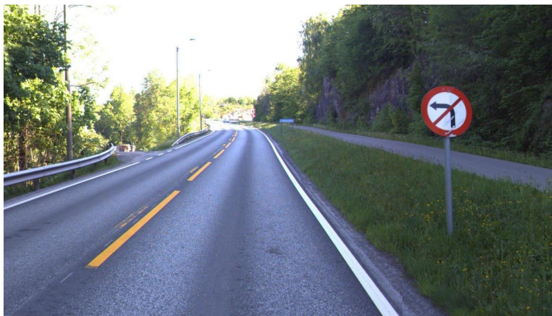
Figur 1 Svingerestriksjon (Foto: Statens vegvesen)
