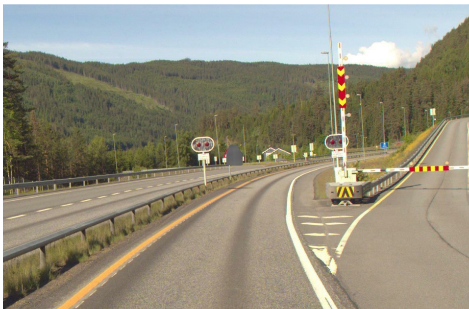
Figur 1 Vegbommer (Foto: Vegbilder, Statens vegvesen)
