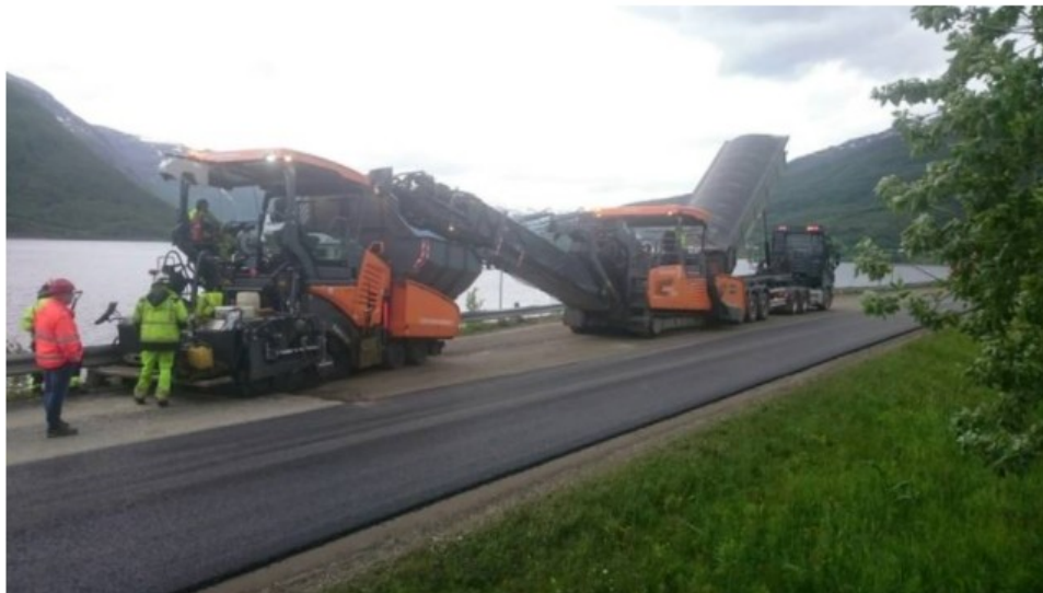
Figur 1 Vegdekke (Foto: Kåre Nygård, Statens vegvesen)
