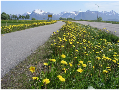
Vegstrekning med trafikkdel mellom veg og GS-veg. Foto: Statens vegvesen
