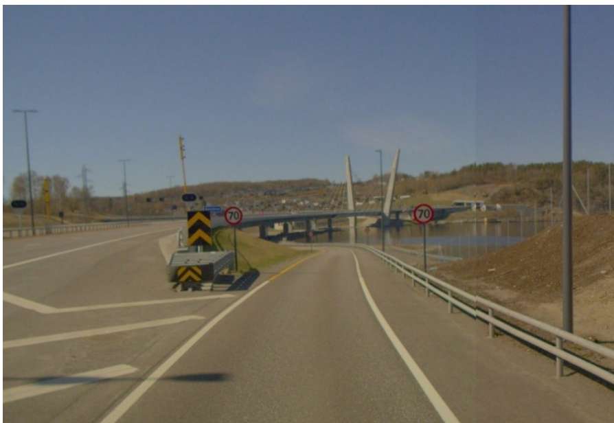
Figur 7, Foto: Statens vegvesen
