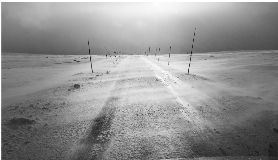
Figur 1 Værutsatt veg på Valdresflye (Foto: Werner Harstad, Statens vegvesen)
