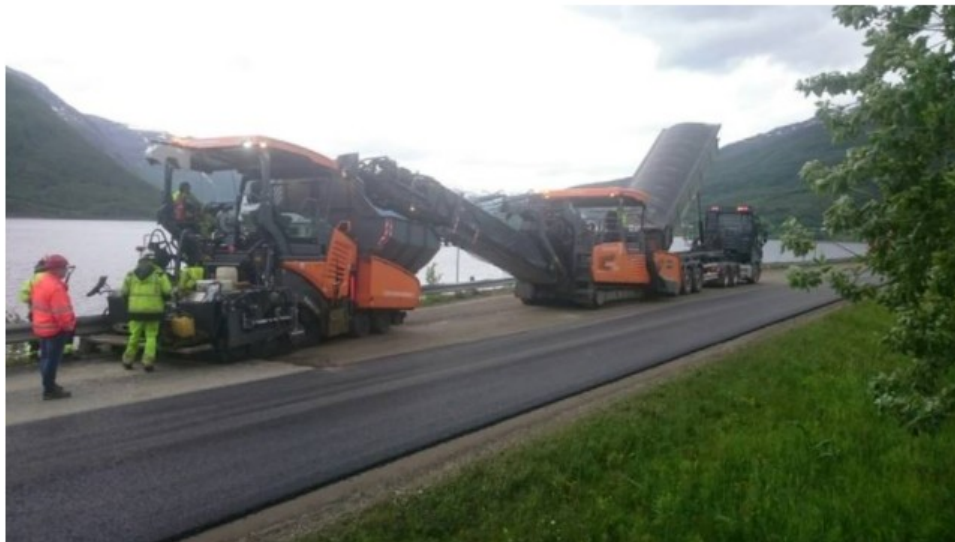
Figur 1 Vegdekke (Foto: Kåre Nygård, Statens vegvesen)
